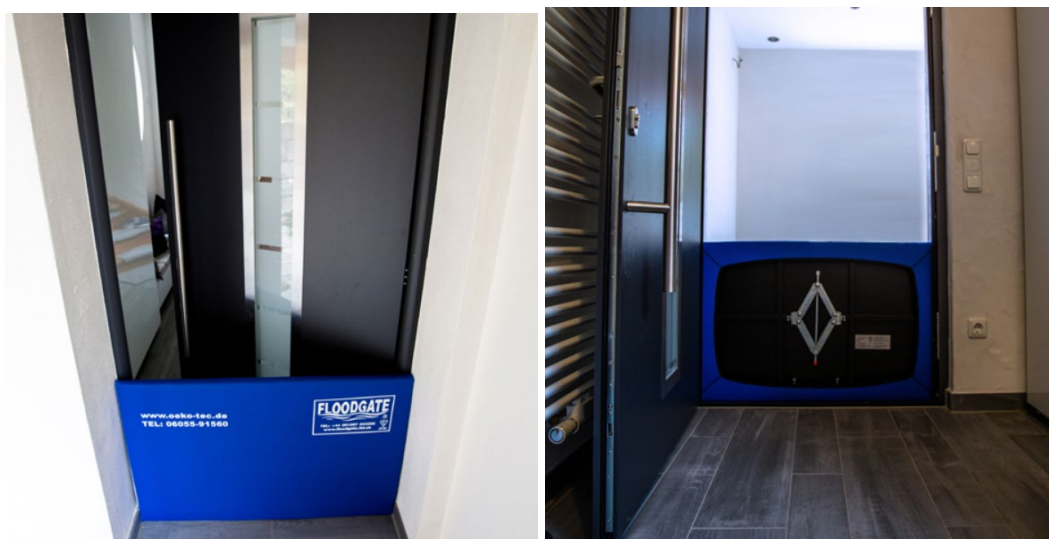
Figur 3. Exempel på semi-permanent översvämningsskydd (installerat skyddsläge) – Floodgate
